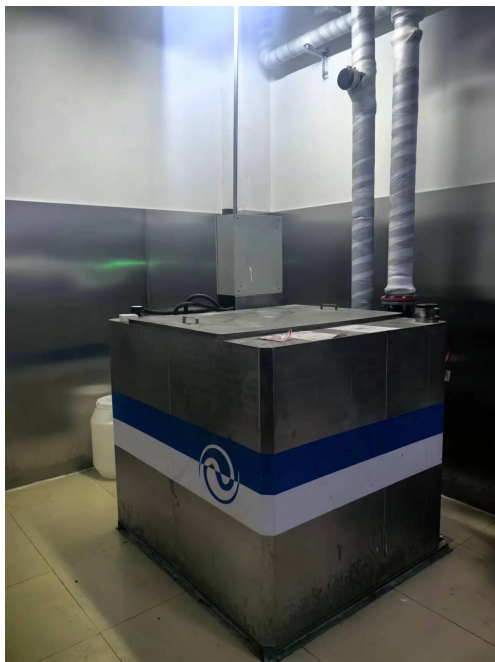
污水池改造后
